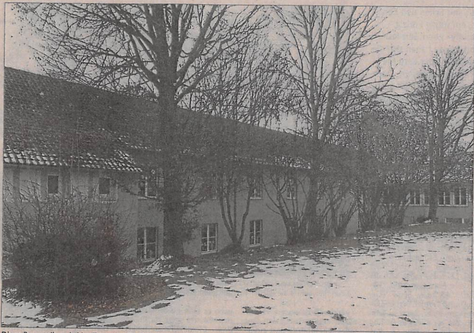
Diese Baumreihe wird im Zuge der Dachsanierung des vorderen Schulgebäudes und des Hallenneubaus beseitigt. Die Gemeinderäte beschlossen einstimmig, dass dies die Firma Niefer übernimmt. Auch die Sträucher werden entfernt.
